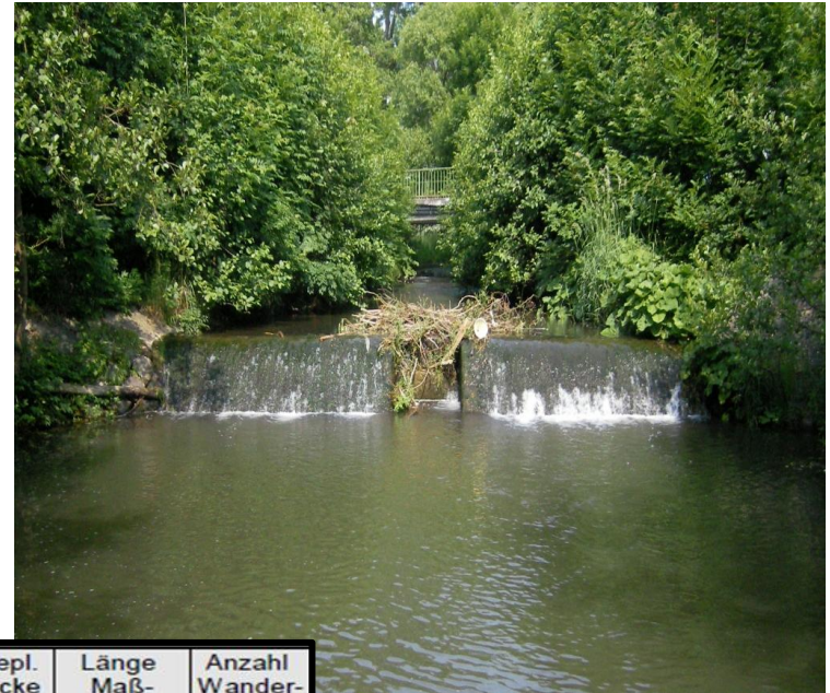
Einstiegswehr Ulmbach – Absturzhöhe ca. 1, 20 m plus Tosbecken
